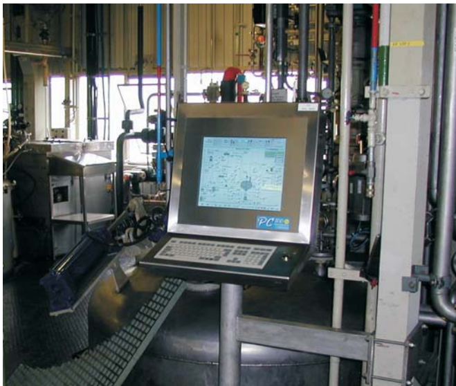
Bild 3: Gönzheimer PC100-Bildschirmarbeitsplatz mit kombinatorischem Explosionsschutz.
